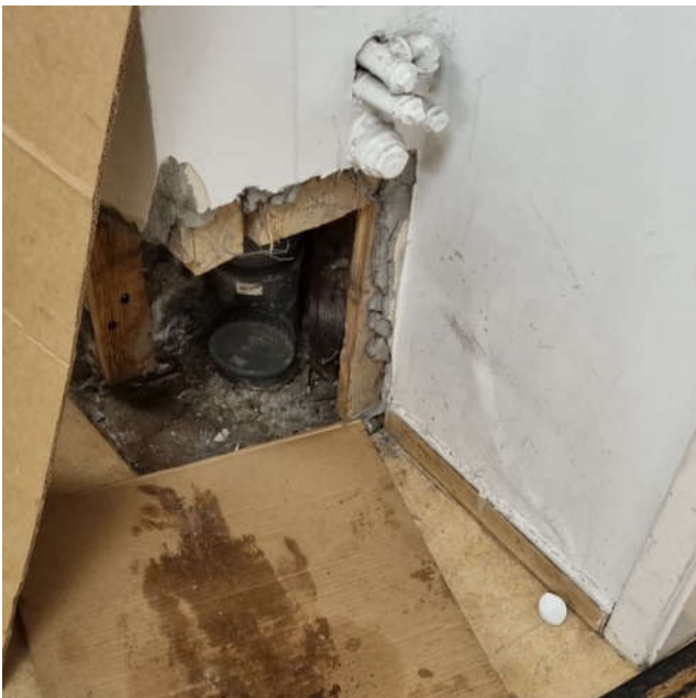
MYND 6 Þakniðurfall og rakaskemmdir þar sem þakniðurfall kemur niður í Þrísteyni 1.hæð, nemendaaðstöðu.
