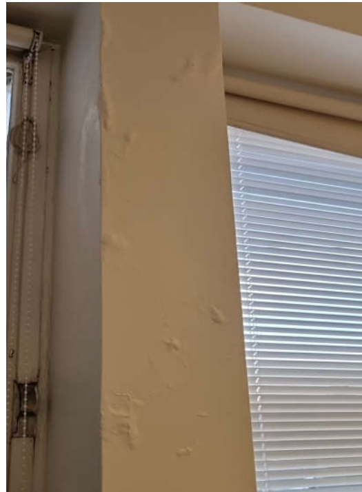
MYND 5 Súla í Þrísteyni 3. hæð þar sem þakniðurfall rennur í gegn.
