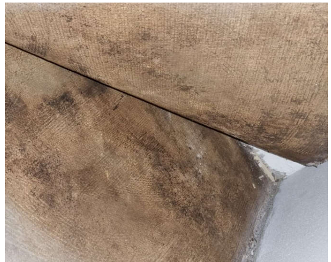
MYND 7 Myglaður og rakaskemmdur gólfdukur í tæknirými í Loftsteini á 1. hæð.
