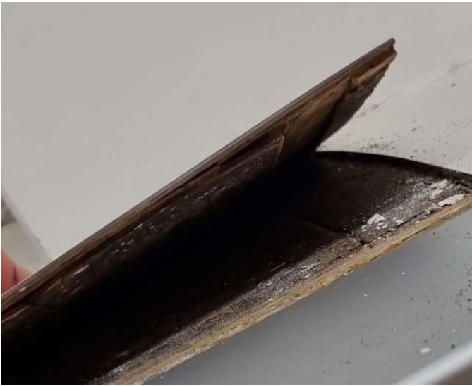
MYND 4 Rakaskemmdur og myglaður sólbekkur í Þrísteyni 3.hæð.
